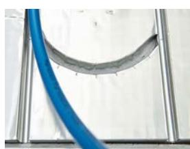
Двигаясь по рисунку, соответствующему способу укладки трубопровода, вернуться к распределительному коллектору и отрезать трубу с запасом 20-30 см.
