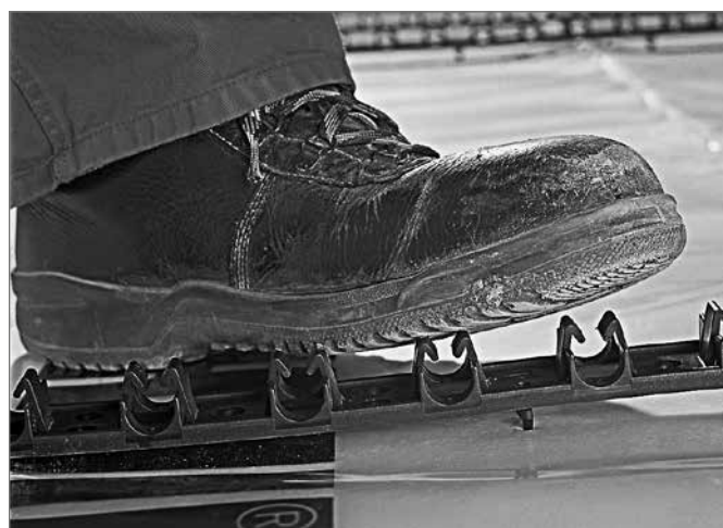
Рис. 21-46 Вдавливание фиксирующих шин RAUFIX в конструкцию пола
