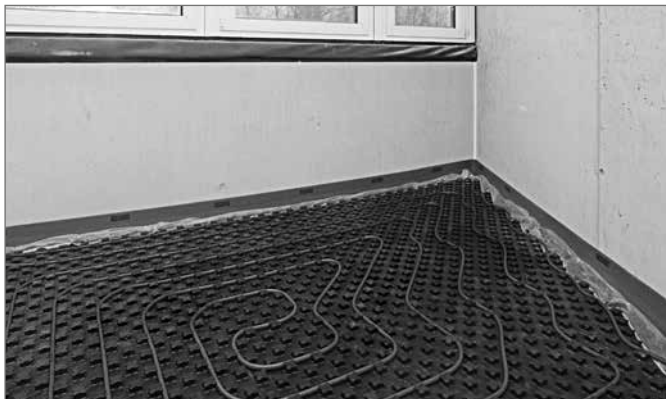
Рис. 21-22 Маты с фиксаторами Varionova с шагозвукоизоляцией 30-2 снизу
