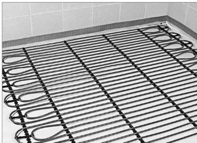
Рис. 21-67 Напольная фиксирующая шина для «мокрого» способа монтажа
