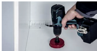
Шаг 2 Просверлите вентиляционное отверстие и установите блок RE.SOURCE в шкаф.
