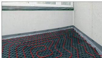
Рис. 15.5-13 Маты с фиксаторами Varionova с шаго - звукоизоляцией 30-2 снизу
