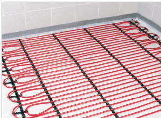
Рис. 15.5-37 Напольная фиксирующая шина для мокрого способа монтажа
