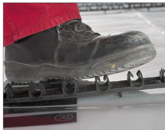
Рис. 15.5-11 Вдавливание фиксирующих шин RAUFIX в конструкцию пола
