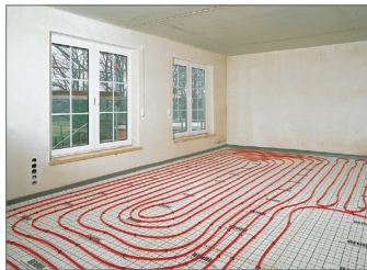
Рис. 15.5-1 Система крепления труб с помощью гарпун-скоб
