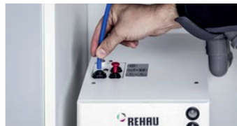
Шаг 3 Подключите трубки холодной и горячей воды к блоку, вставьте вилку устройства в розетку.
